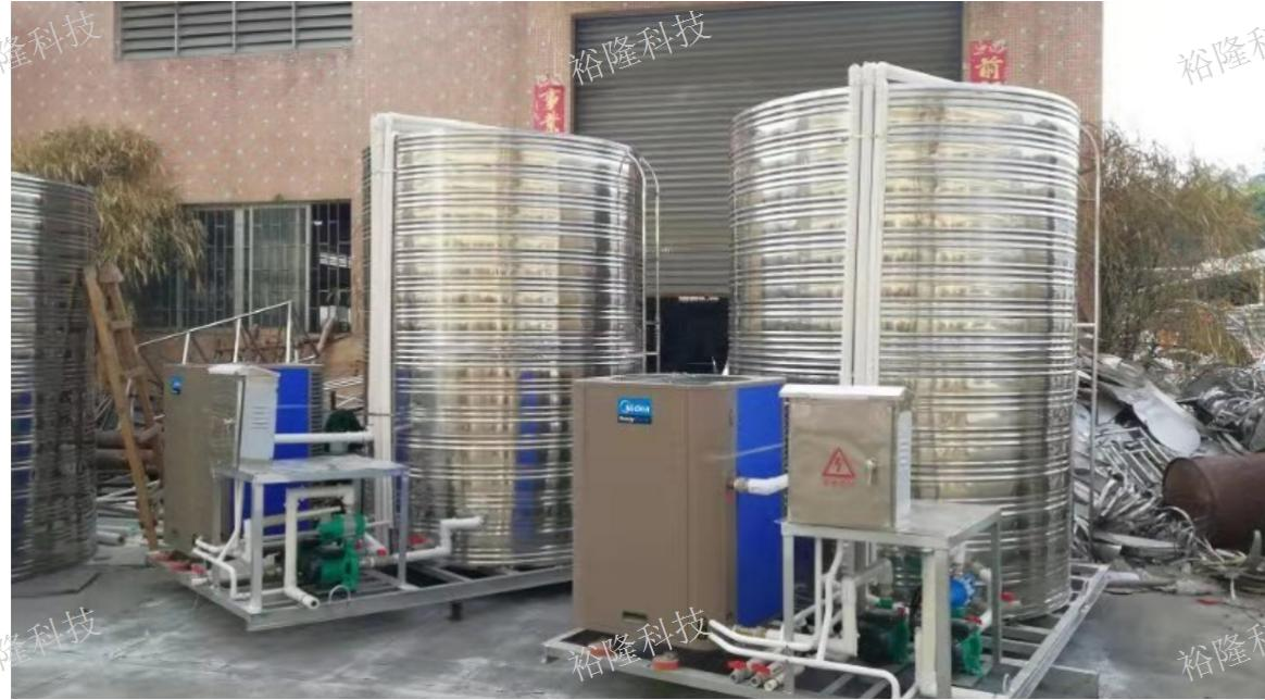
空气能热水器需要安装在通风的场所，如果是施工安装放置于室内制热效率很差；还有管道布置要合理，如果管道水箱安装的位置不合理，机组无法正常运行，也是不制热的。4、换热器结垢空气能热水器换热器结污垢没有及时清理，换热器结垢不清洗，板式换热器容易胀破，套管式换热器的内管会破裂，导致整个机组失去功能，所以空气能热水器不制热。员工宿舍空气能热水器安装总之，空气能热水器已经成为很多家庭、商用的像宾馆酒店、学校医院、工厂厂房、办公楼宿舍楼等集中热水供应场所的主要选择，即便是阴雨天也可以产生热水，而且节能环保、相比较其他热水器设备而言具有很好的优势，用户在遇到空气能热水器不能制热的问题的时候先可以根据上述原因查找，或者根据说明书上的故障代码进行查看，自己不懂的切记不要去维修，联系厂家专业人员上门查看。
