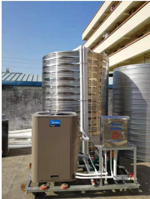
空气温度迅速降低变成冷气释放。 随后吸收了一定能量的冷媒回流到压缩机，进入下1个循环。 空气源热水器能够将空气中的低温热能吸收，并且在机器内部转化为高温热能，然后加热水温，空源热泵热水器非常的节能，而且效率也非常的高。 毋庸置疑，空气能热水器较大的优点就是节能。 将空气中的低温热能通过压缩机转化为高温热能，以相同的热水制造量为基准，和电热器热水器相比，较大化节约电能，使用成本只有电热水器的1/4，而和传统的燃气热水器比，不用耗用任何的煤气燃料，
